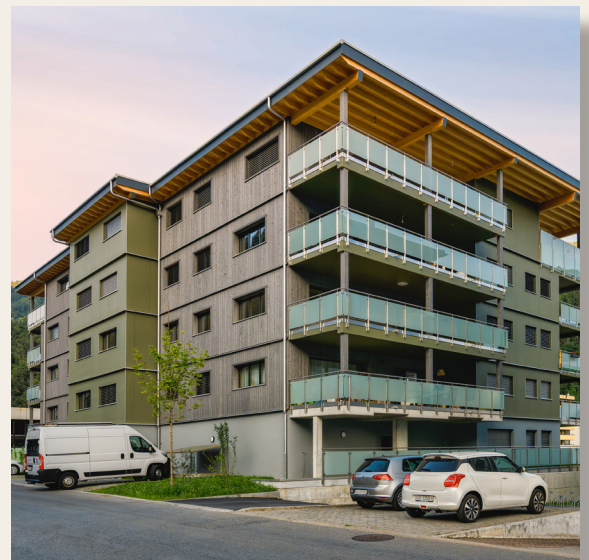
Abbildung 7: MFH Balkon, Archiv Holzbau AG
