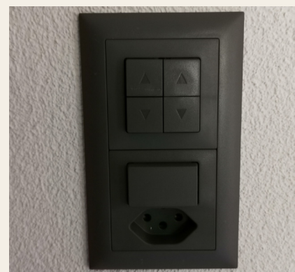
Abbildung 12: E-Inst., Archiv Holzbau AG
