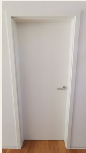
Abbildung 8: Tür 1, Archiv Holzbau AG
