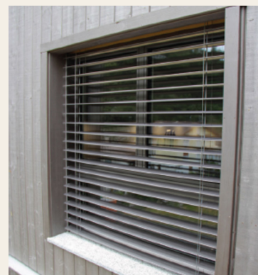
Abbildung 15: Sonnenschutz 2, Archiv Holzbau AG
