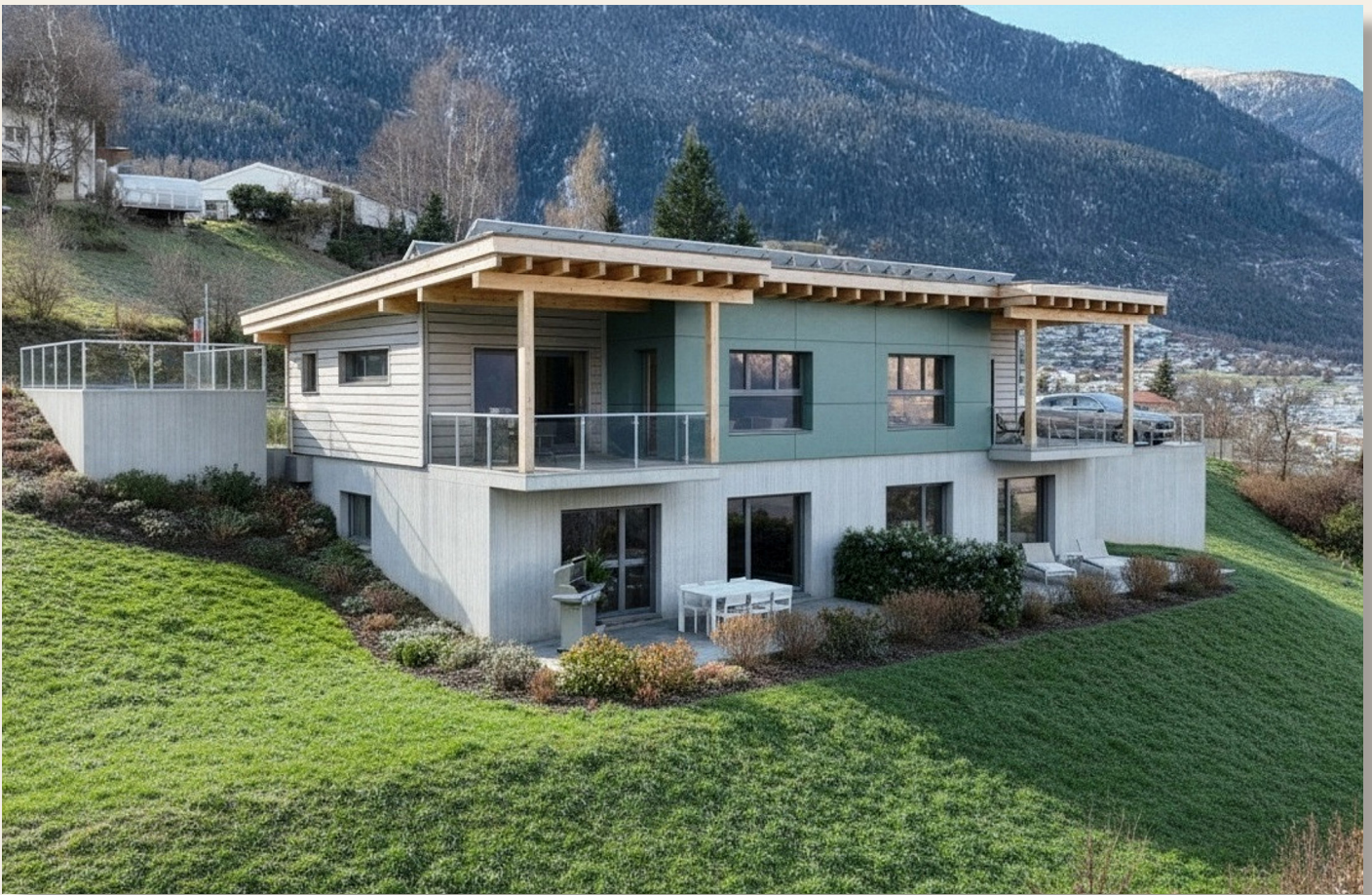
Abbildung 2: Visualisierung Aussenansicht, Archiv Holzbau AG
