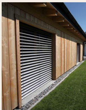
Abbildung 14: Sonnenschutz 1, Archiv Holzbau AG
