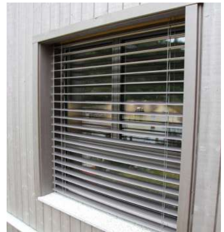
Abbildung 7: Sonnenschutz 2, Archiv Holzbau AG
