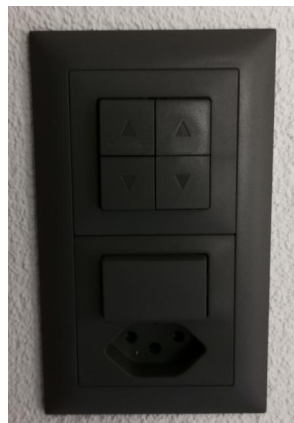
Abbildung 11: Elektrische Installationen, Archiv Holzbau AG
