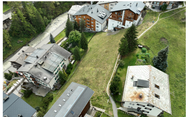
Abbildung 7: Bauparzelle MFH «Roots», Archiv Holzbau AG
