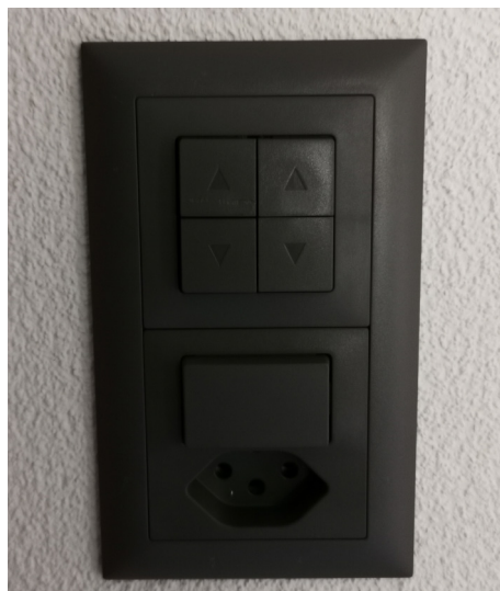
Abbildung 17: Elektrische Installationen, Archiv Holzbau AG
