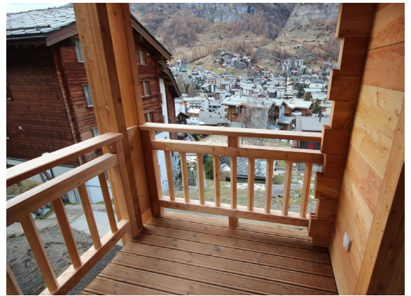
Abbildung 11: Holzgeländer, Archiv Holzbau AG
