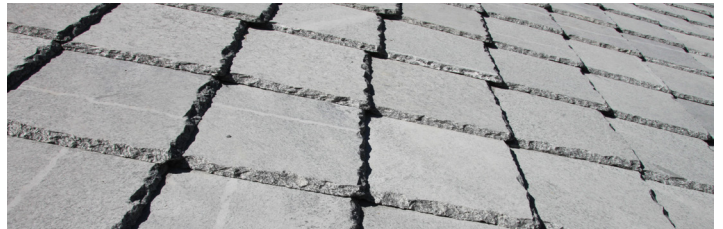
Abbildung 9: Dach Natursteinplatten, Archiv Holzbau AG
